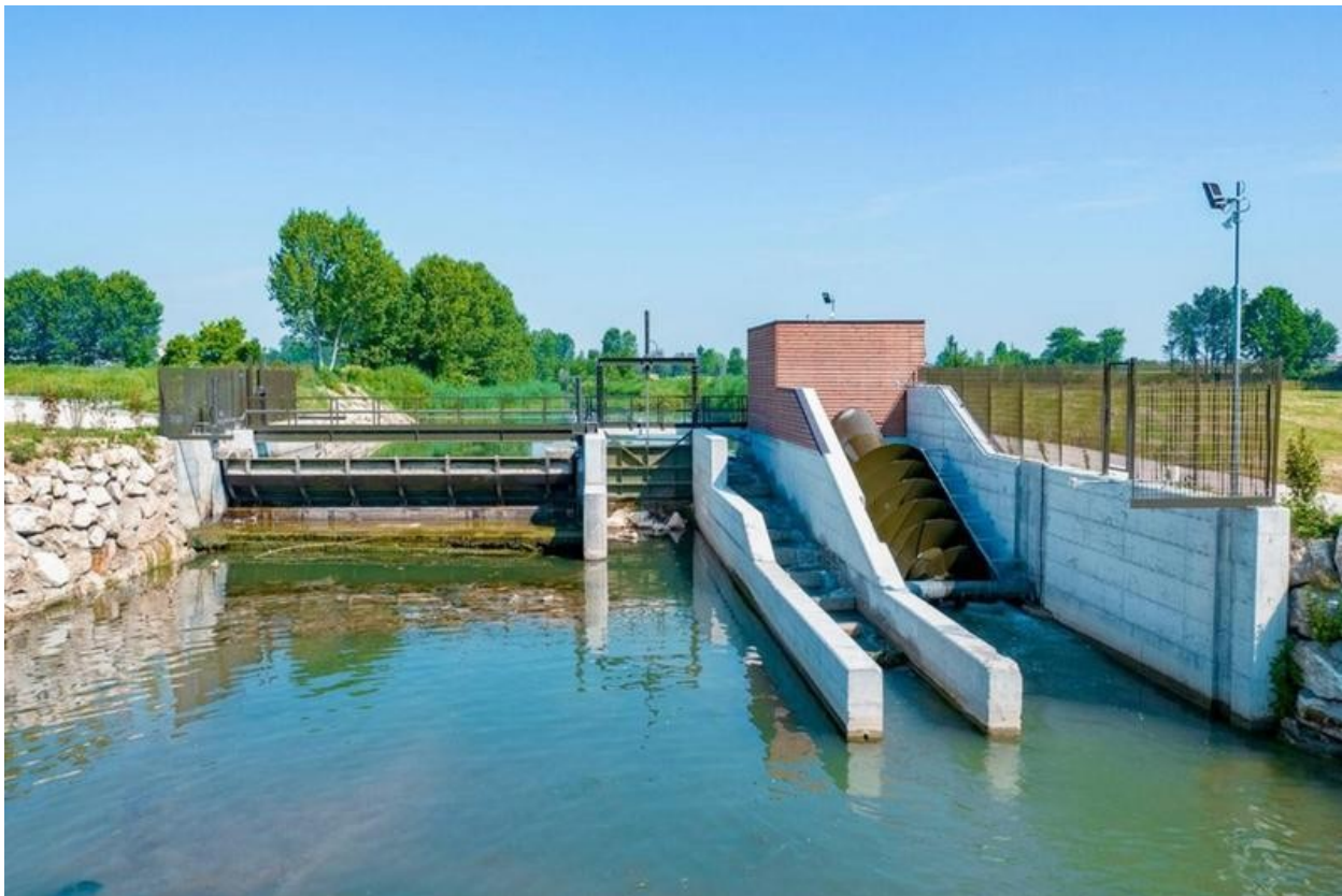
La nuova centralina sul fiume Gambara (BS) . La turbinq ha una potenza massima di 100 kw.
